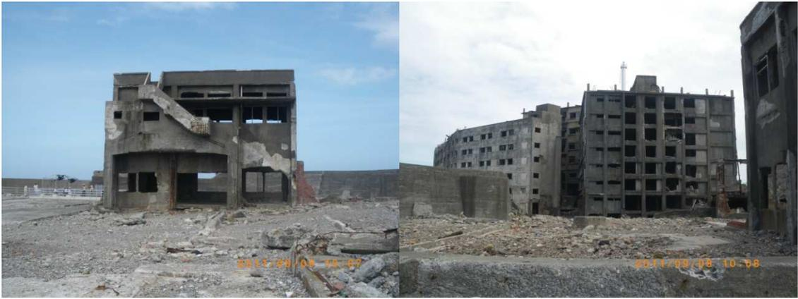
これは第 3 見学広場からの写真である。住宅地の団地跡である。このような廃墟化は台風などの自然の力による。例えば団地は当時まだサッシを使っていなかったため、木造の窓枠が腐って欠落しコンクリート部だけが残されているという。世界遺産の登録を目指しているが、時と共に破壊が進んでいくのをどう食い止めるのだろうか。
