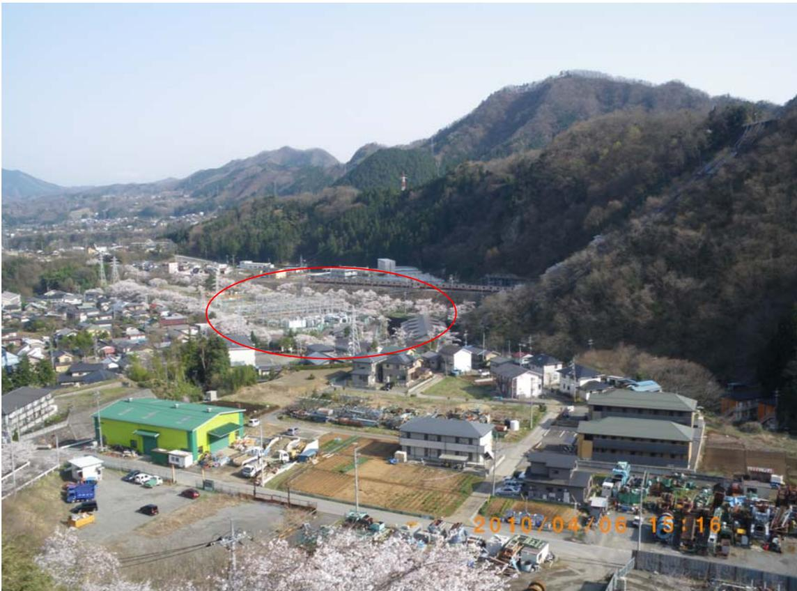
正面中央に東電の八ツ沢発電所、その先に JR 中央本線が走っています。ここは大月にある葛野川揚水発電所の運転スターターの役もしています。右手の山上に大野調整地があり、上流の発電所で用いた水を溜めて、必要なときに発電しています。中央の桜に囲まれて見えるのが変電所です。
