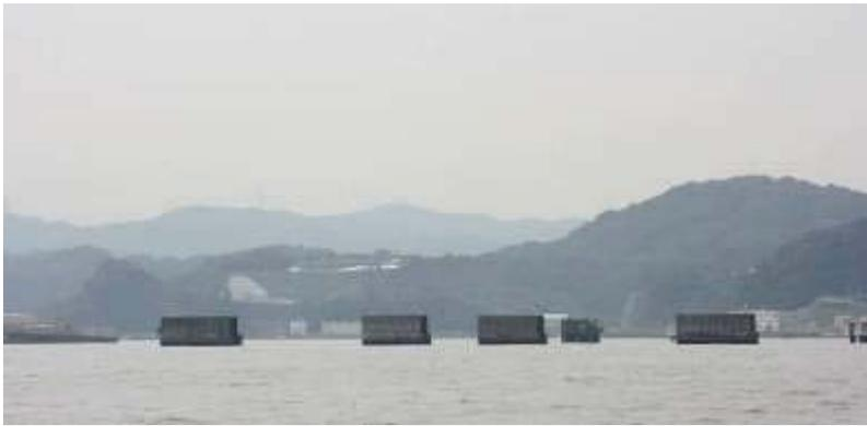
この四角い豆腐のようなものは、船の消磁機だぞ。海の上でも走り続けていると静電気のように、磁気を帯びるんだそうで・・・電子兵器に影響を与えないように、ここに一度接岸してから係留埠頭に向かうのだ。
