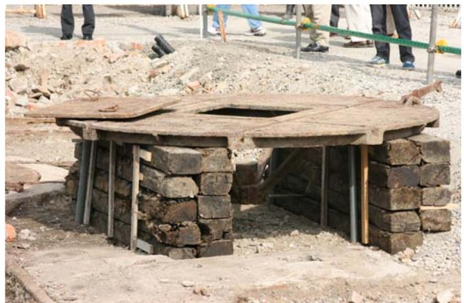
浅目の井戸のような構造で下の方にコロのようなものが並んでいるのが分かります。天板だけを取り出したのが、上の写真です。比較的厚い铸铁で車輪の通るところだけスリットが切ってあります。
